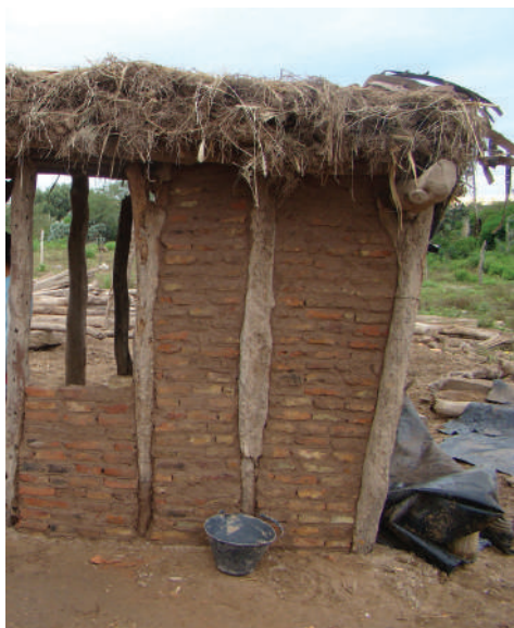
Figura 14. Casa Silva (mayo 2014): construcción de muro de ladrillos entre postes. Fotografía: Constanza Taboada
