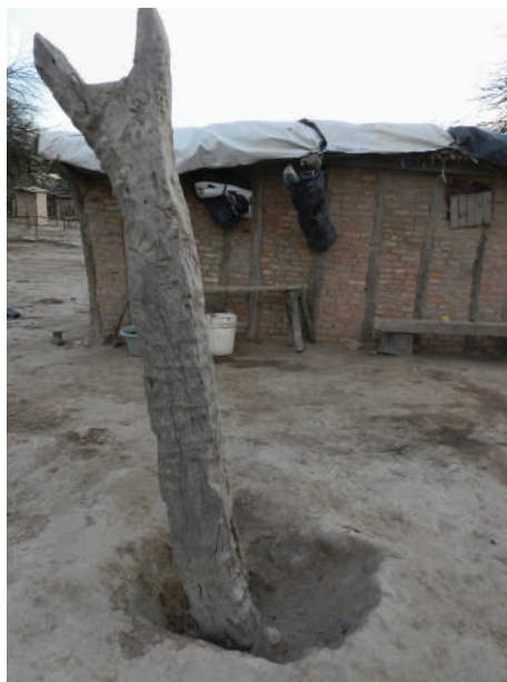
Figura 16. Casa Silva (agosto 2014): horcón que quedó en pie tras tres meses de desarmado el recinto; atrás la nueva construcción. Fotografía: Constanza Taboada
