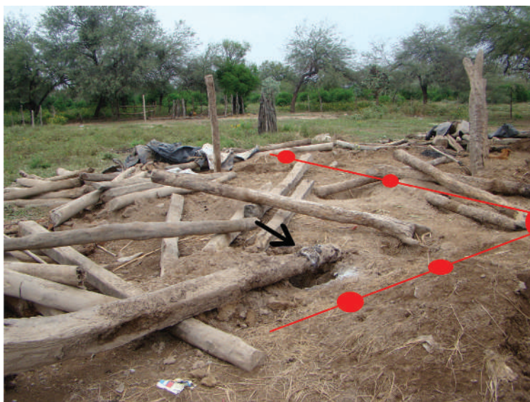
Figura 8. Casa Silva (mayo 2014): vista de los materiales desmontados in situ ; se indican con línea y puntos rojos la ubicación de algunos de los hoyos de horcones en distribución ortogonal; con flecha se indica el residuo negro y blanco presente en la base de poste. Fotografía: Constanza Taboada
