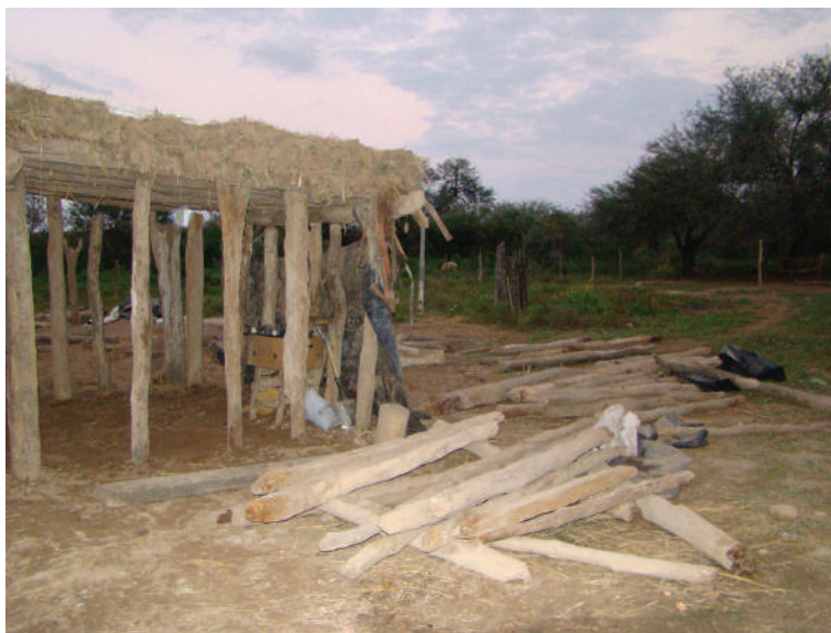
Figura 11. Casa Silva (mayo 2014): nuevo recinto en proceso de construcción reutilizando los materiales del recinto desmantelado. Fotografía: Constanza Taboada
