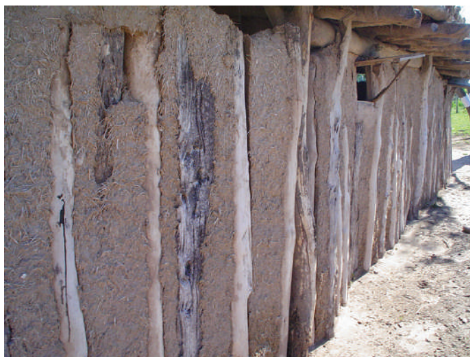
Figura 6. Casa Silva: muro de palo a pique con revoque de barro perteneciente al recinto desmantelado en mayo de 2014 (foto de 2005). Fotografía: Constanza Taboada
