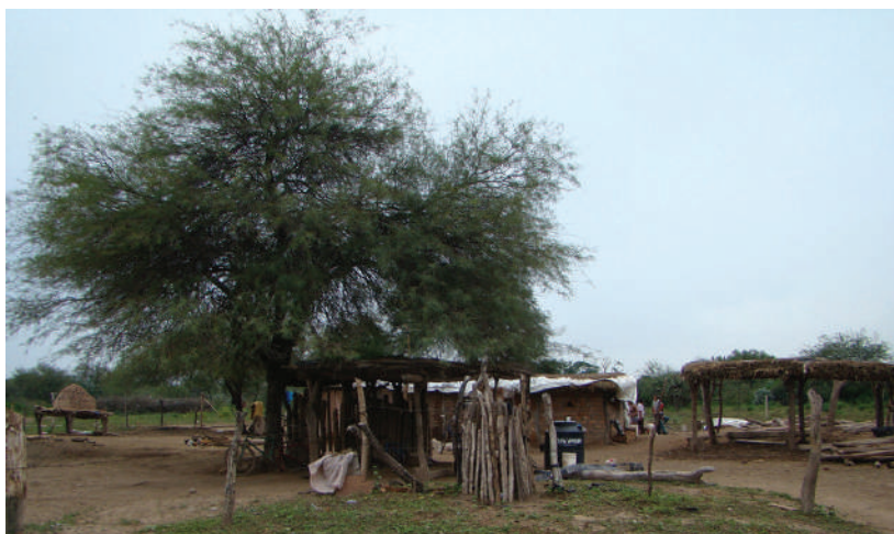
Figura 12. Casa Silva (mayo 2014): vista del nuevo recinto a medio hacer y restos del desarmado con relación a otros ambientes construidos en uso. Fotografía: Constanza Taboada
