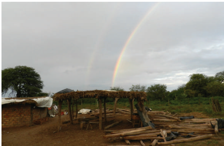
Figura 7. Casa Silva (mayo 2014): vista del proceso de desarme y construcción de un nuevo recinto. Fotografía: Constanza Taboada
