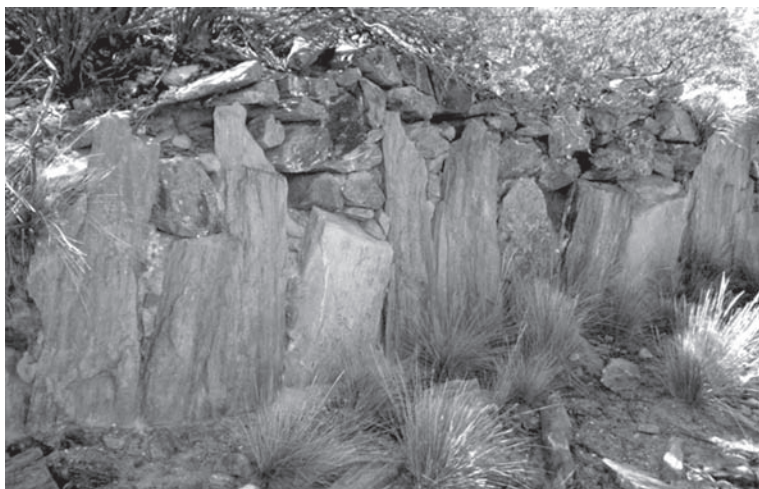
Figura 9. Pared NE del recinto 37 (Conjunto VII), construida con grandes lajas paradas
