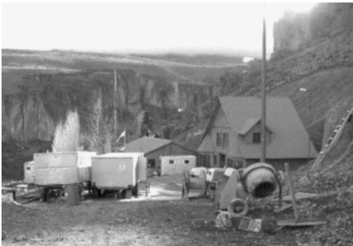
Foto 1. Vista general de las instalaciones en el sector de estacionamiento, casa para guías, casa del guardia y trailers de la empresa constructora (foto M. Colombo)
