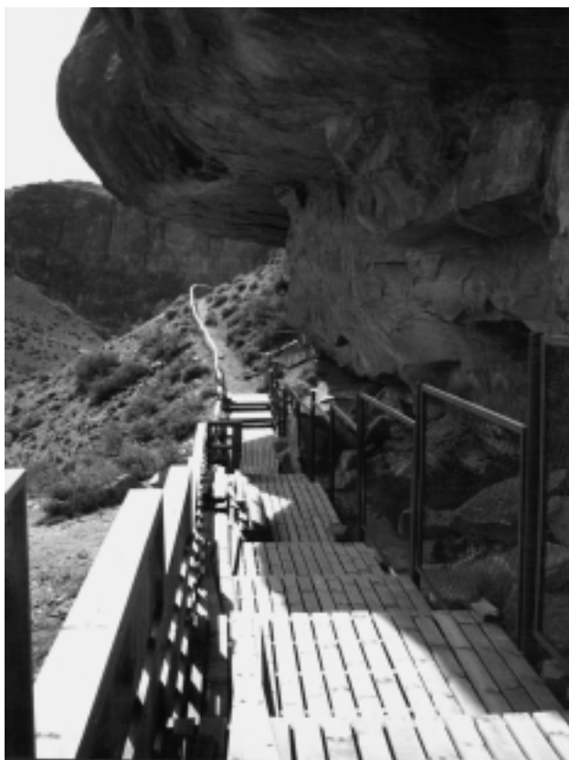
Foto 7. Pasarela y deck ubicados en el sector II frente a la cueva (foto M. Colombo)
