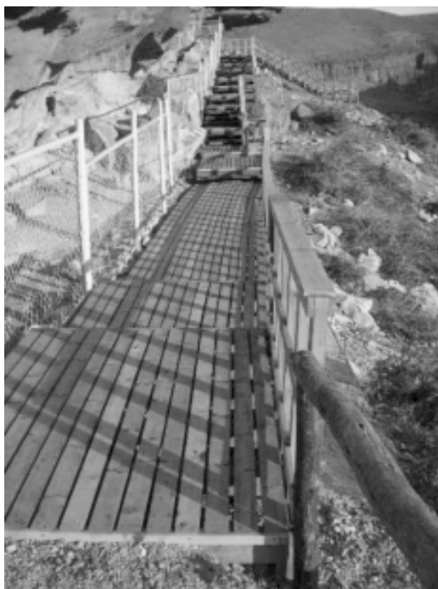
Foto 10. Vista de las pasarelas del sector IV (foto M. Colombo)
